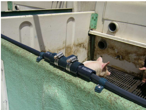
写真 1 煙霧ノズル設置状況
