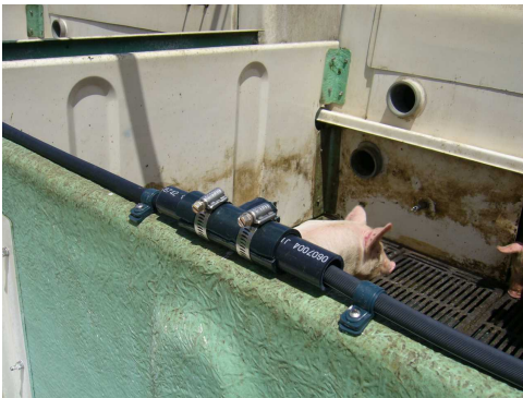
写真 1 煙霧ノズル設置状況
