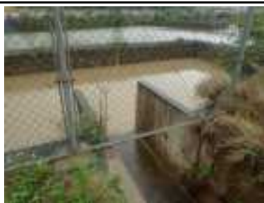
⑲ 沈砂池の状況(オーバーフロー有り、濁りなし)
