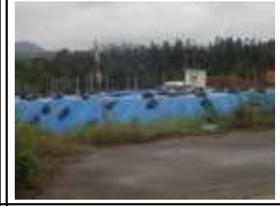
⑬ 工事現場の状況
