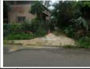
⑭ 水が噴き出す箇所 (濁水流出)
