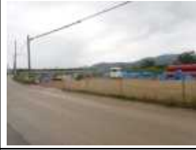
⑬ 工事現場の状況
