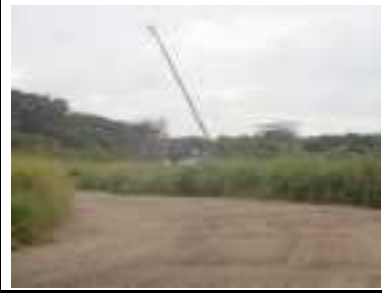
⑫ 工事現場の状況
