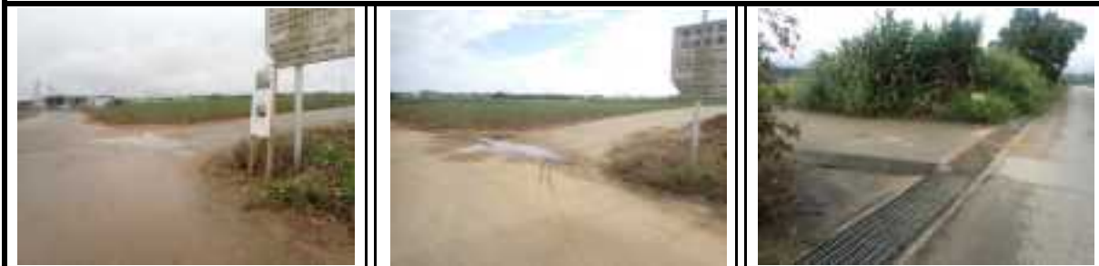
⑨ サトウキビ畑から道路や側溝へ赤土等の流出痕状況
