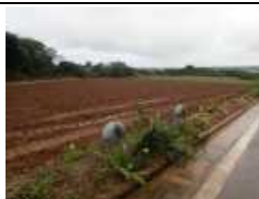
⑯ 工事現場の状況
