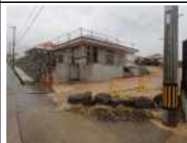
⑪ 宅地建設工事の状況
