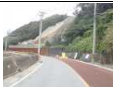
⑧ 災害復旧工事の状況
