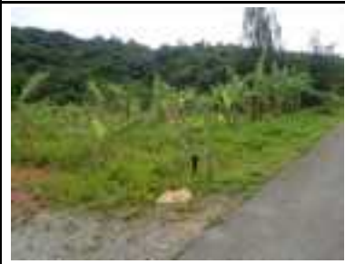
⑬ バナナ園から道路へ赤土等の流出痕状況
