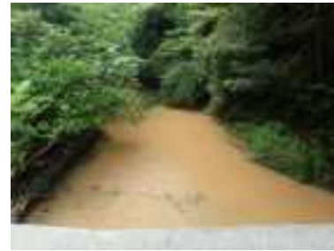
③ 地点②の上流にある砂防ダムの状況(濁り有り)
