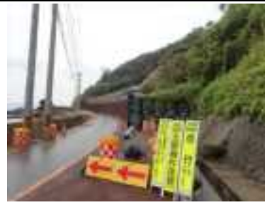
⑧ 災害復旧工事の状況
