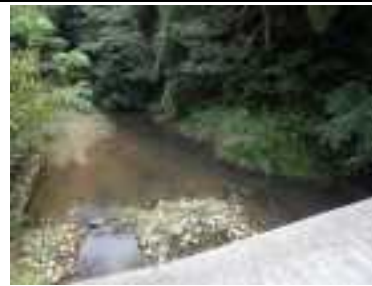
③ 地点②の上流にある砂防ダムの状況(濁りなし)
