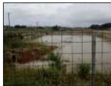
②沈砂池の造成
