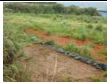
⑪ 土のうによる赤土等の流出防止対策
