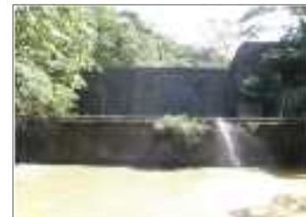
③ 砂防ダム
