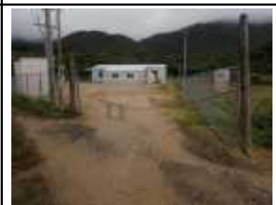
⑭ ヤードの状況
