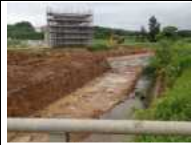
⑨ 工事現場の状況
