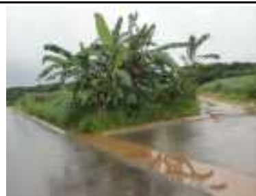
⑬ グリーンベルトによる赤土等の流出防止対策
