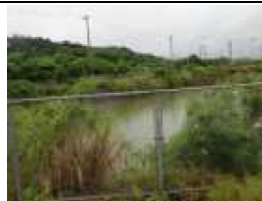
⑯ 沈砂池の状況
