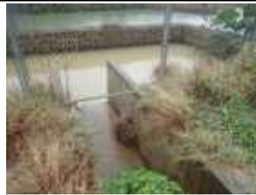
⑯ 沈砂池の状況
