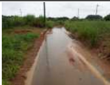
⑧ 農地から道路や側溝へ赤土等の流出状況
