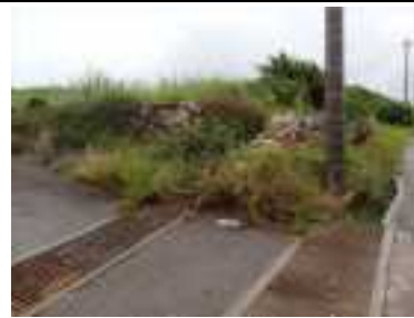
⑫ 勾配修正による赤土等の流出防止対策
