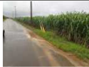
④ サトウキビ畑から道路へ赤土等の流出状況
