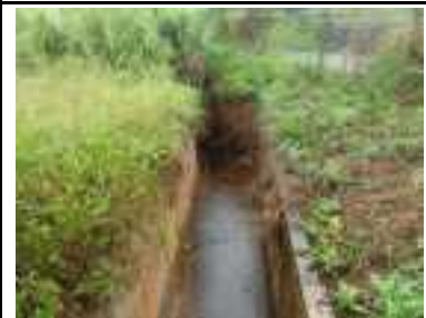
⑰ 沈砂池の状況
