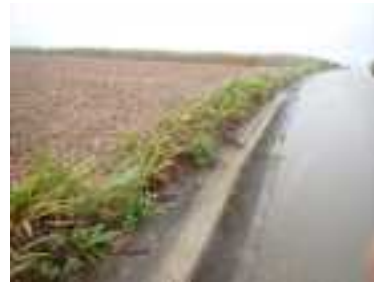
⑮ グリーンベルトによる赤土等の流出防止対策
