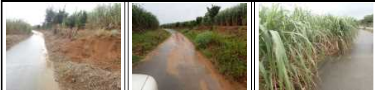
⑩ サトウキビ畑から道路へ赤土等の流出状況
