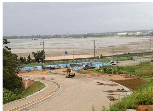
地点⑨ シートで囲われた工事用沈砂池
