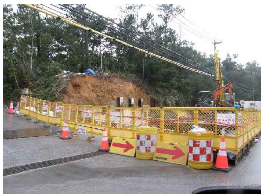
地点⑩ 下水道工事状況
