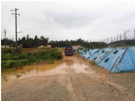
地点⑧ 工事状況(向かって右側に工事用沈砂池)
