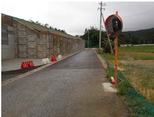
地点② 橋梁上部工事完了状況
