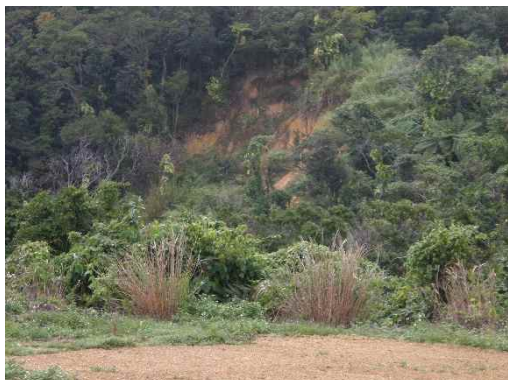
地点⑤ がけ崩れ後草本が覆う(改善)
