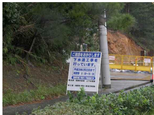
地点⑩ 工事看板
