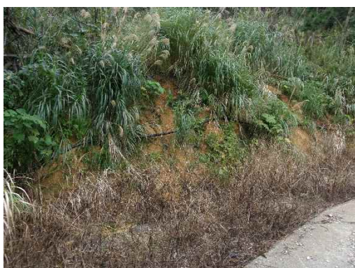
地点⑥ がけ崩れ後草本が覆う(改善)
