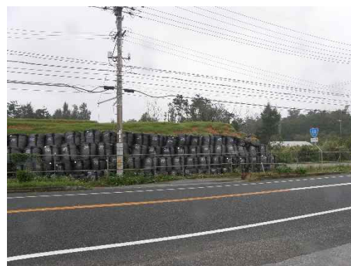
地点⑨ 土嚢により赤土流出防止(改善)
