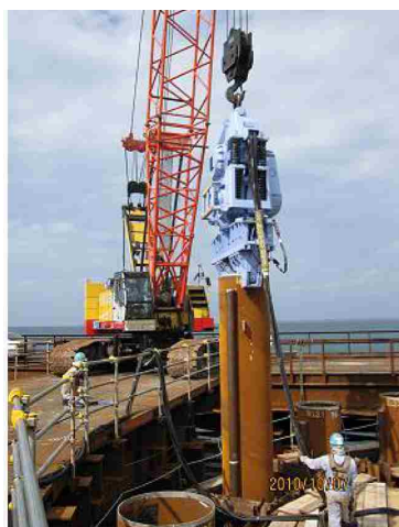
現場の施工状況
