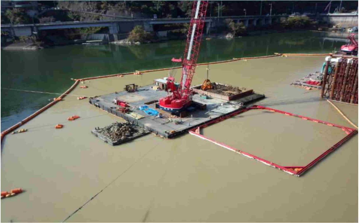
汚濁防止膜を設置して浚渫を行っている状況
