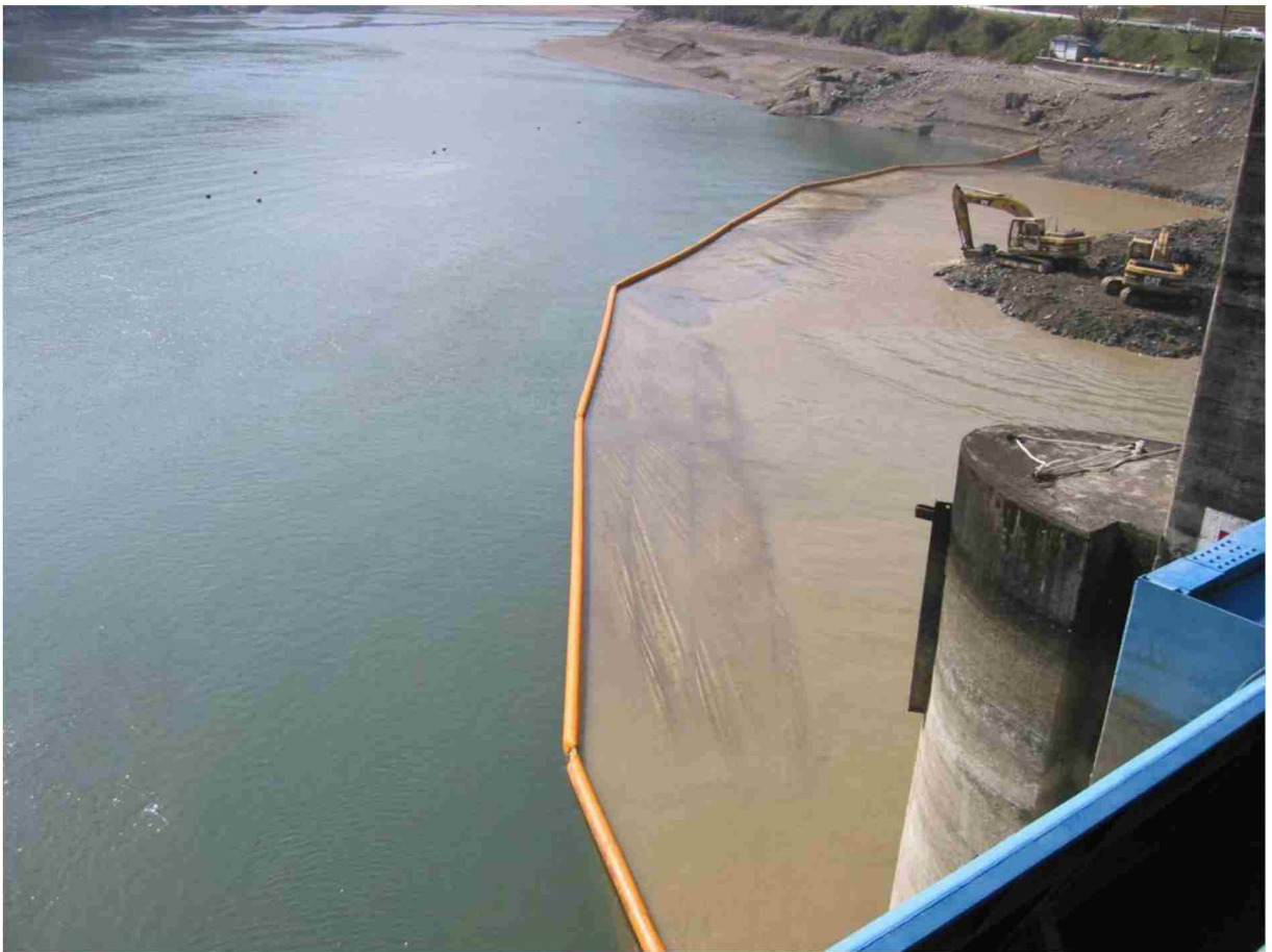
汚濁防止膜を設置して土砂を投入している状況
