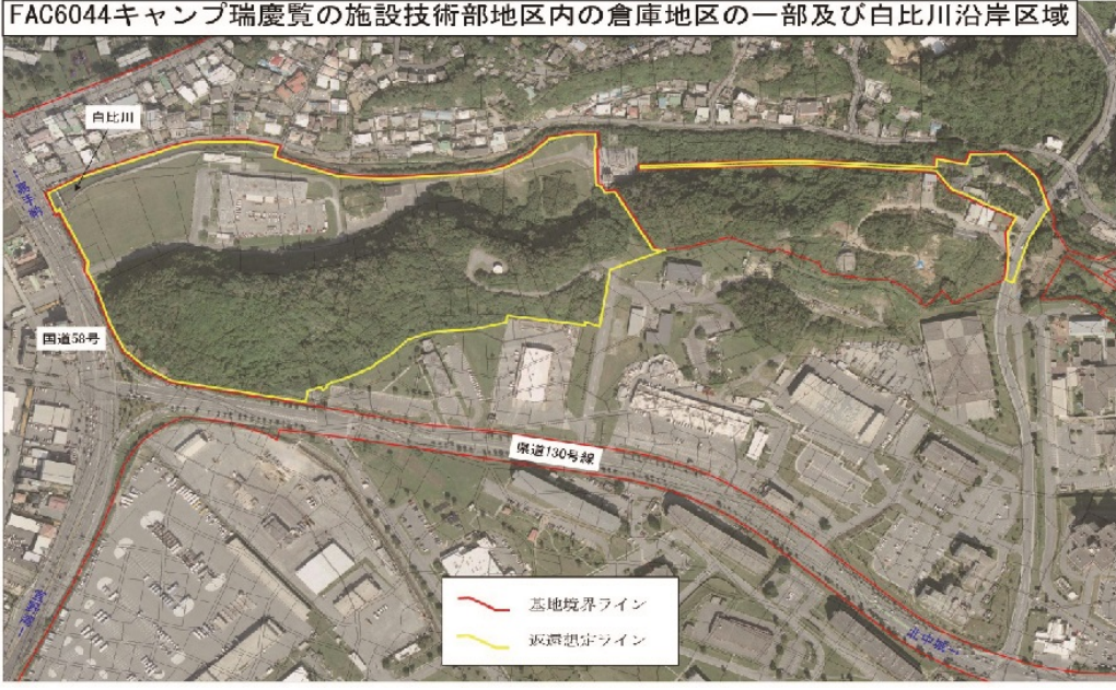
図IV-7 キャンプ瑞慶覧の倉庫地区の一部及び白比川沿岸区域の航空写真
