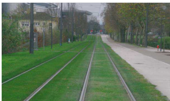
【フランス・ストラスブール郊外の専用区間芝生軌道の例】
