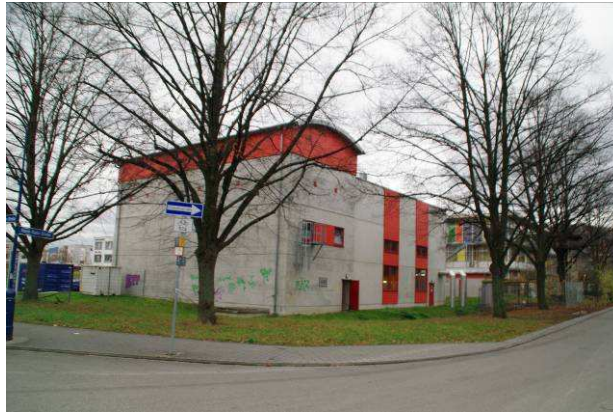
図 2.20 エコプラントの例（フライブルク・ボンバーン団地）
