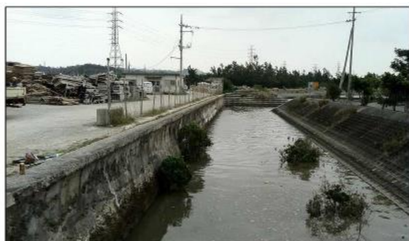
整備前状況 / 中城湾港海岸(熱田地区)
