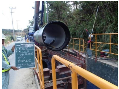
導水管布設工事写真
