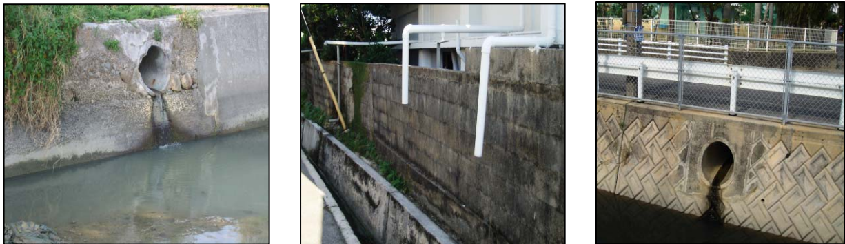
図2-14 中城湾港沿岸における排水管及び排水の状況
