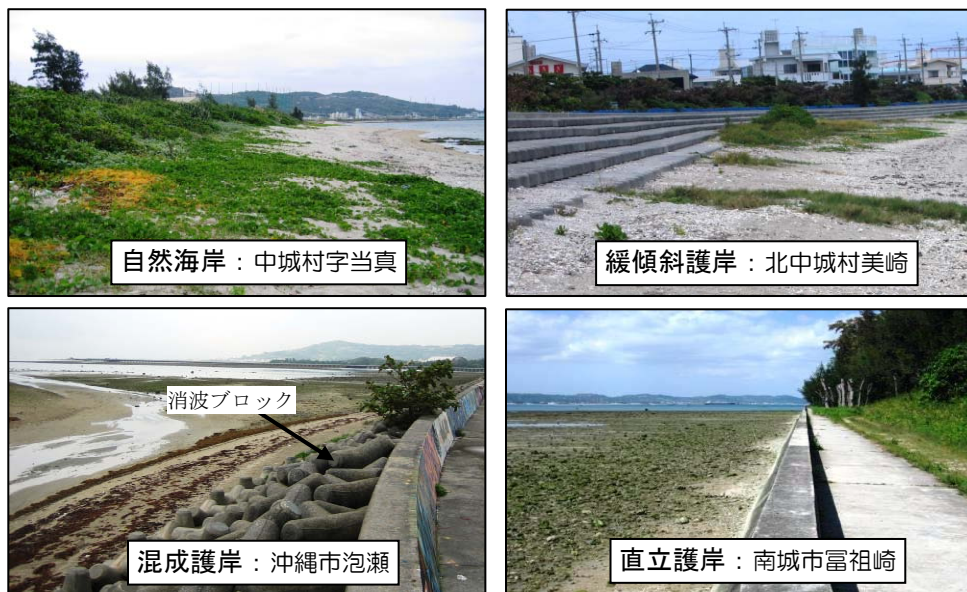
図 2-8 護岸の種類と整備状況
