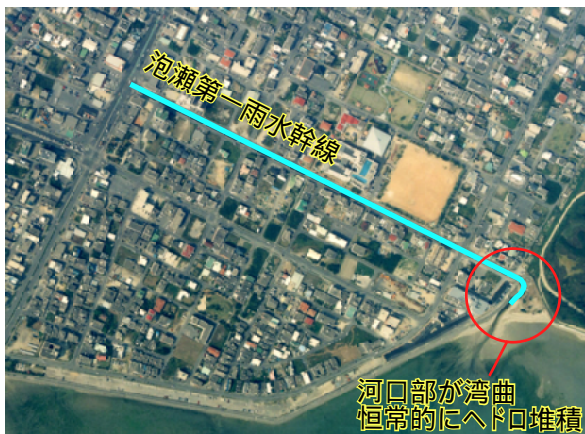
泡瀬第一雨水幹線 全区間が直線状水路であるが河口部のみ大きく湾曲
