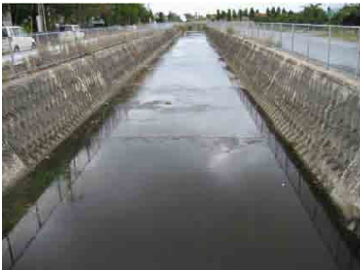
コンクリート三面張り泡瀬第一雨水幹線
