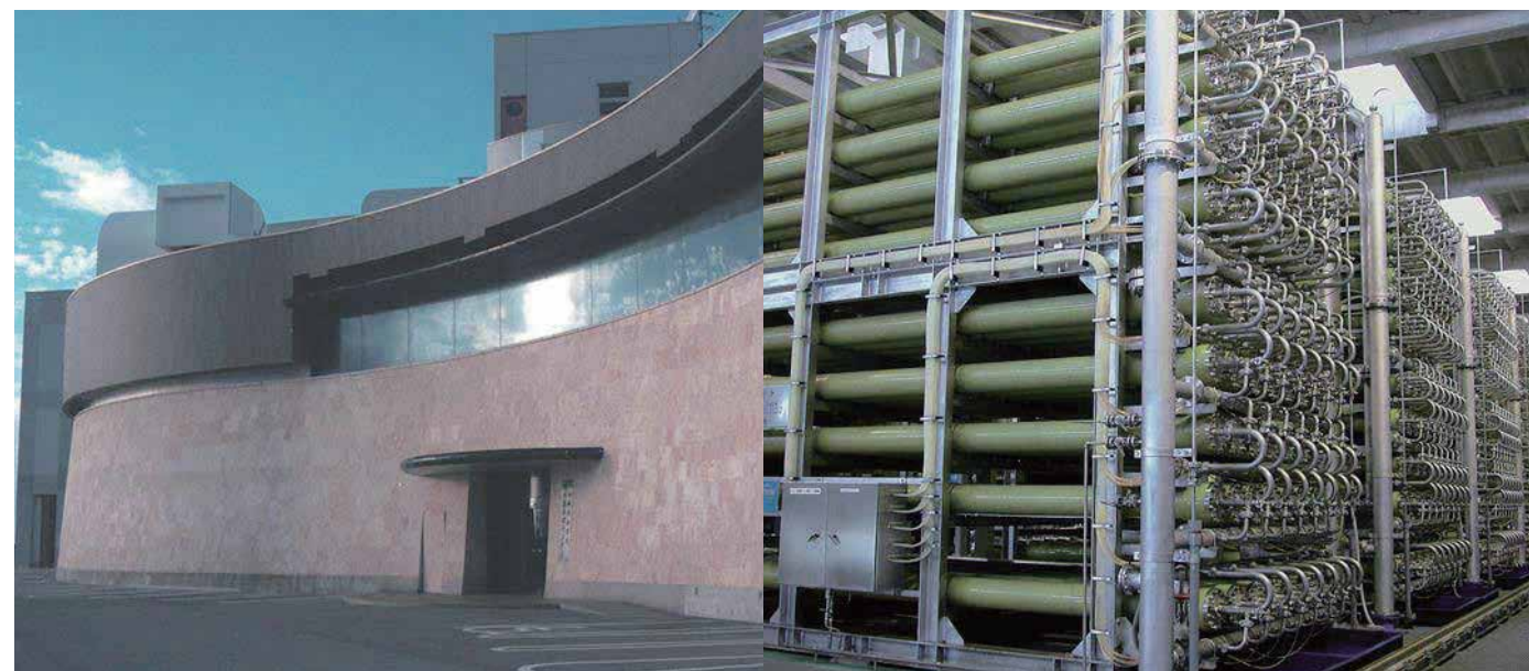
海水淡水化センター (沖縄県企業局)
