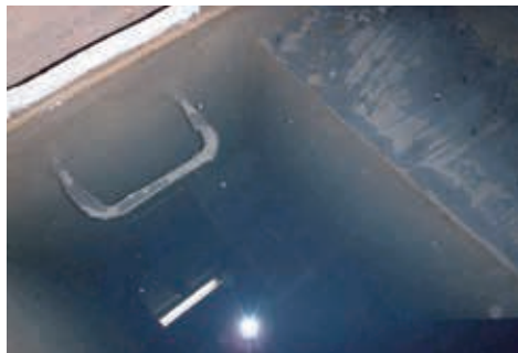
沈殿槽の例（西原小学校）
