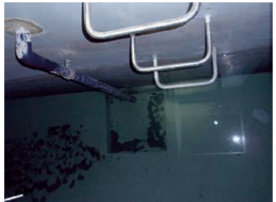
雨水貯留槽内部
