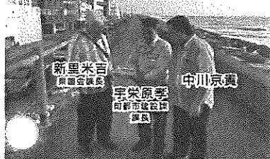
H30.10月台風25号 状況現場調査
