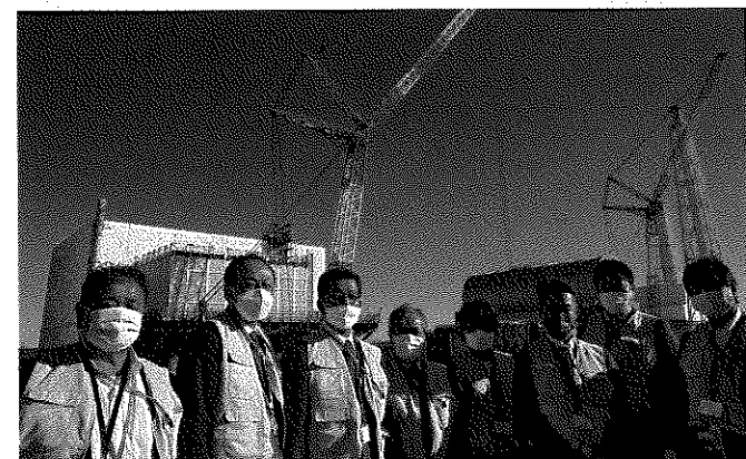
福島第一原子力発電所
