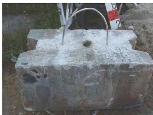
図 5-3-4. 新設アンカーブロックの構造.
