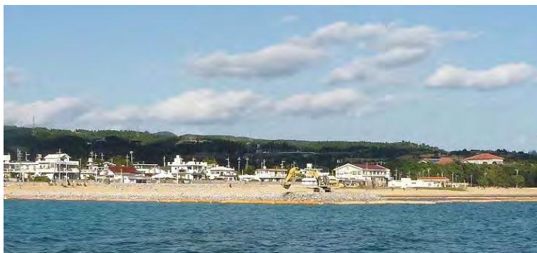
図2-1-39. 埋め立て工事の様子
