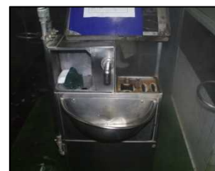
平成8年の腸管出血性大腸菌O-157の集団食中毒事件をきっかけに、平成14年までにと畜場の設備及び作業の見直しが進んだ。内臓は赤モツ・白モツに分別され、頭部はつり下げ方式、手指及び器具の一頭毎洗浄消毒の義務化により、各所に消毒用の設備が設置された。この時期と畜場の統廃合も相次いだ。
