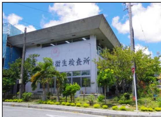
中央食肉衛生検査所 (昭和54年3月～平成26年9月)
