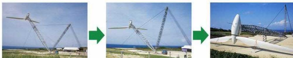
波照間可倒式風力発電設備（傾倒時）
