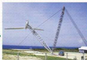
波照間可倒式風力発電設備 (傾倒時)
