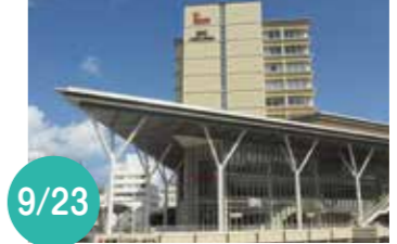
9/23 モノレール旭橋駅周辺地区に那覇バスターミナル、県立図書館、グッジョブセンターおきなわ、沖縄観光情報センター等が入居するカーナ旭橋(A街区)が完成し、竣工祝賀会が開催されました。
