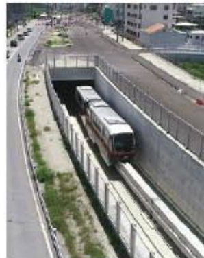
地下トンネル
