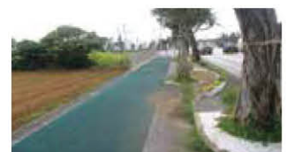
高野西里線 JTAドーム宮古島付近
