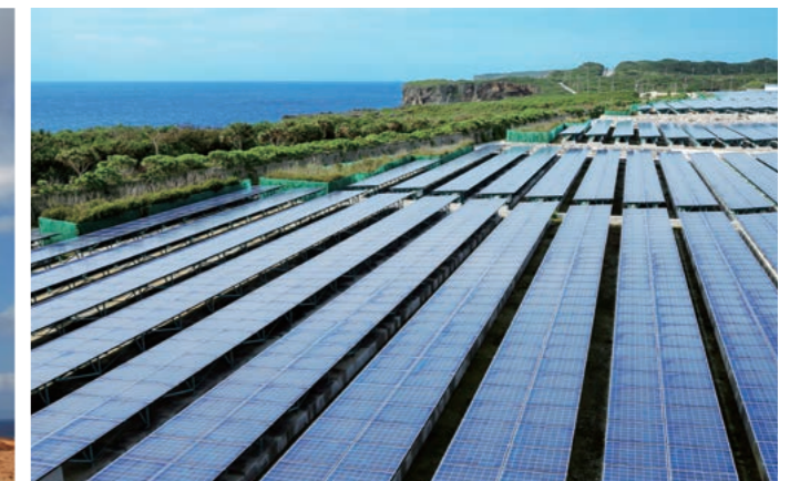
Instalación de paneles de energía solar, una forma de aprovechar la energía natural
