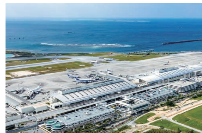
Aeroporto de Naha está sendo desenvolvido para facilitar o acesso (Foto: Naha Airport Building Co., Ltd.)
