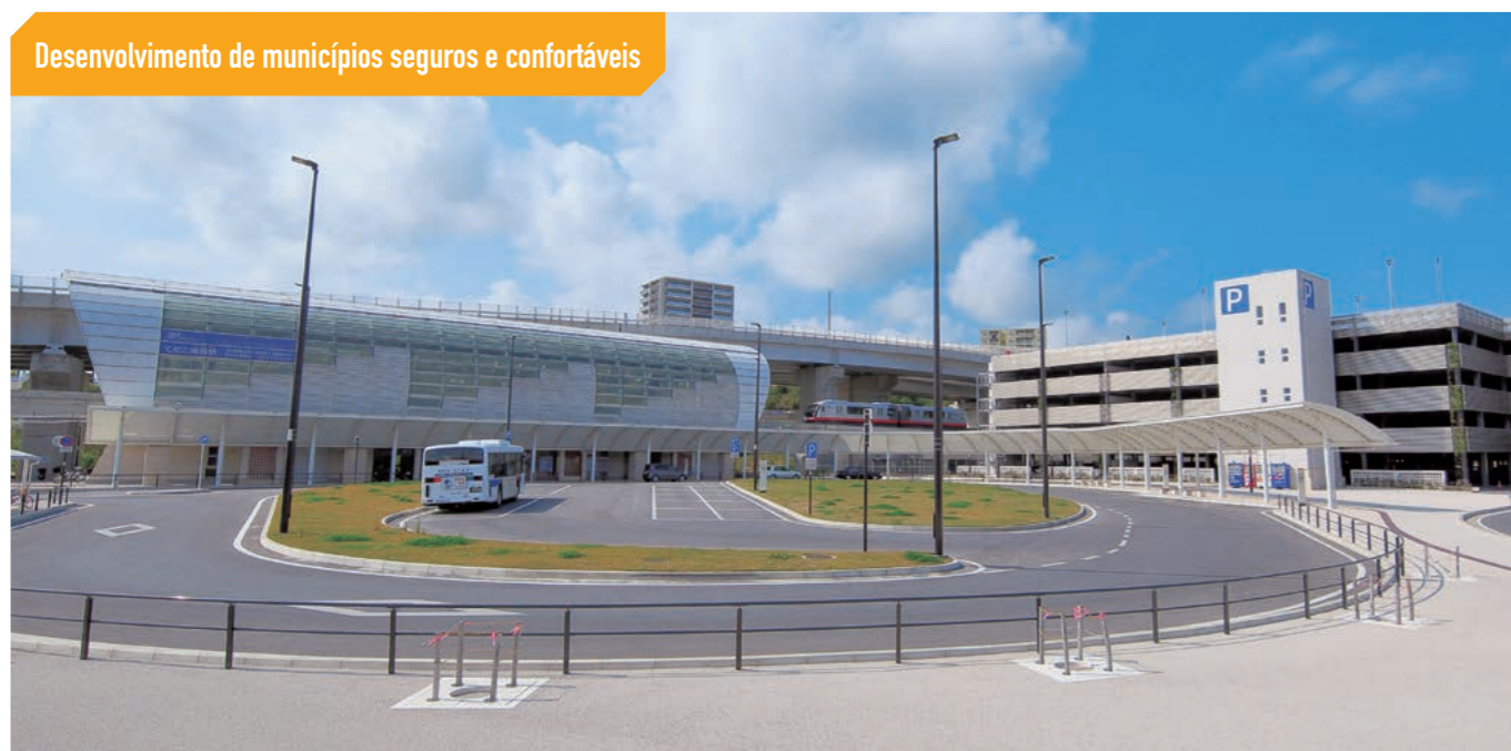
A Estação Tedako-Uranishi foi inaugurada em outubro de 2019, ampliando o Monorilho Urbano de Okinawa. Possui uma grande área de estacionamento e facilita o acesso ao transporte público
