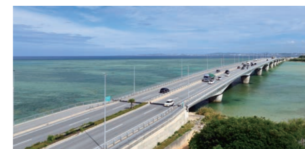
Estrada da Costa Oeste de Okinawa recém-construída
