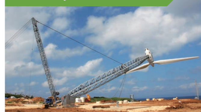
Turbina eólica dobrável e inclinável para prevenir danos de tufões (Foto: Companhia Elétrica de Okinawa)
