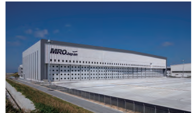
航空機整備施設
