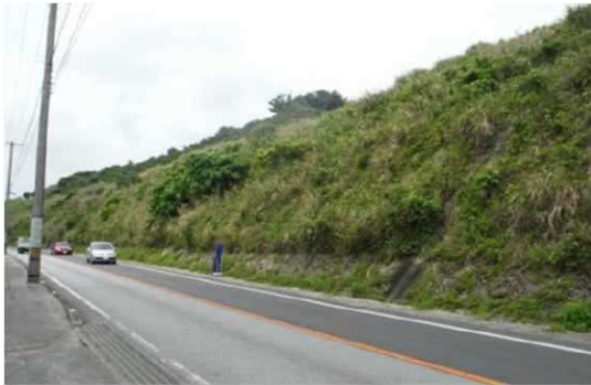
法面对策済みの道路を安全に通行する車両 (南風原知念線)
