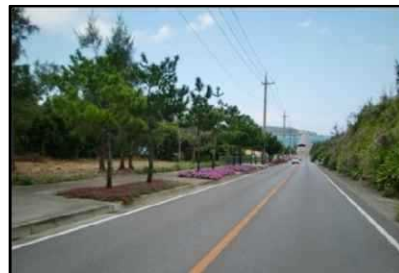
植樹柵：古宇利屋我地線(古宇利大橋)
