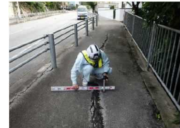
県道146号における舗装点検
