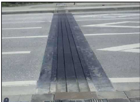
伸縮装置取替【国道449号】
