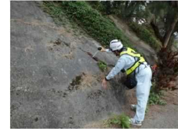
県道146号における法面点検
