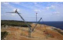
可倒式風力発電設備
