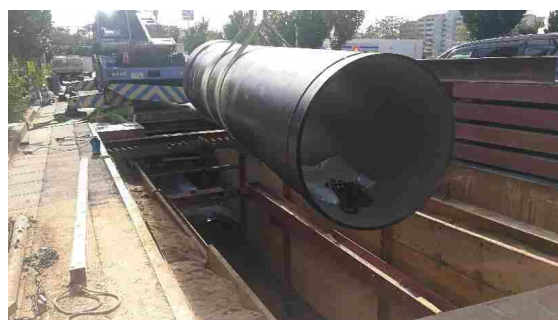
水道施設(送水管)の更新・耐震化
