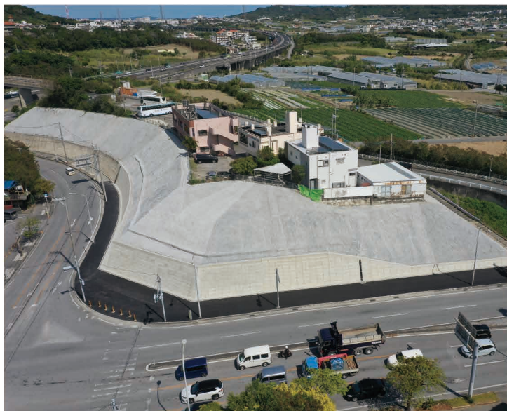
国道507号(山川)災害防除工事
