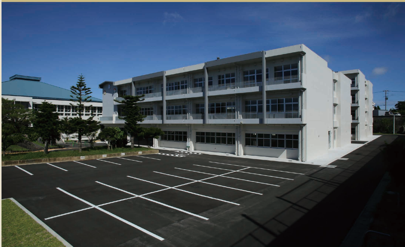
開邦高校・中学校校舎改築工事（第2期）
