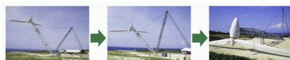
図 4-1 波照間可倒式風力発電設備（傾倒時）
