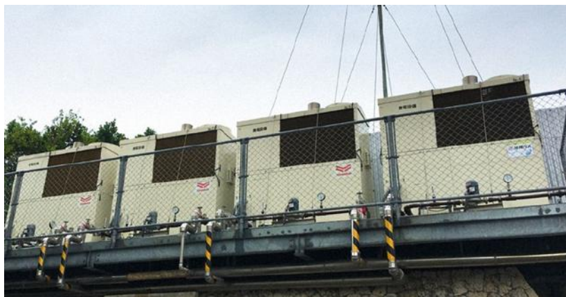
図 4-4 ロワジールホテル&スパタワー那覇におけるガスエンジン・コージェネレーション
