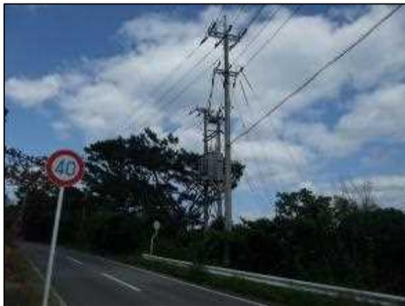
写真㉖ 柱上昇圧調整器 3
