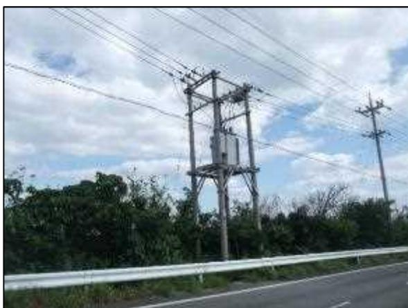
写真㉓ 柱上昇圧調整器 2
