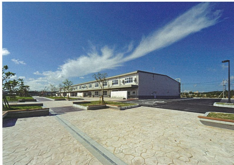
関連工場 東側外観
