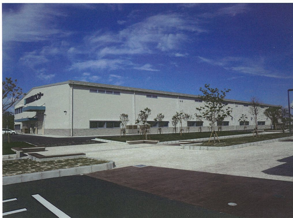
中核工場 東側外観
