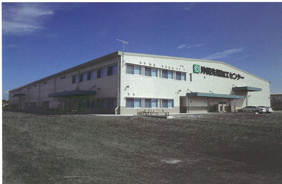
中核工場 南側外観
