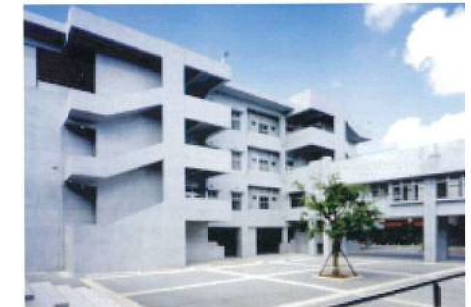
東面及び多目的広場
