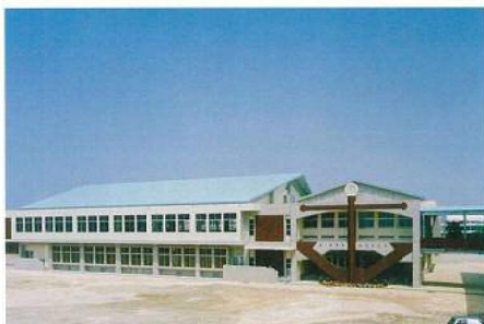
屋内運動場及び武道場
