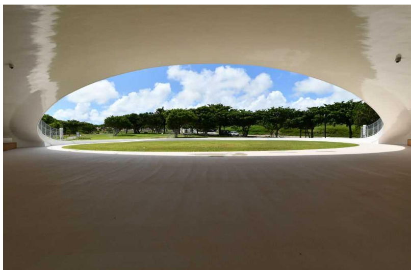
平和祈念公園休憩舎（糸満市）
