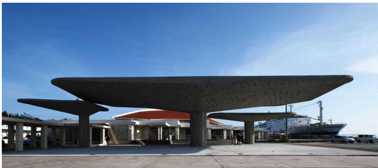
本部港屋根付荷さばき施設（本部町）
