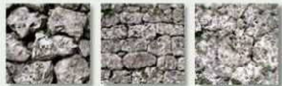
▲野石積み ▲布積み ▲相方積み
