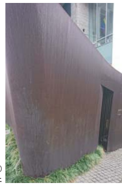
コルテン鋼 施工事例(東京都内) 竣工後5年程度経過 無塗装仕上
