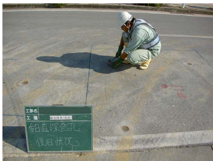
探査孔の埋戻し
