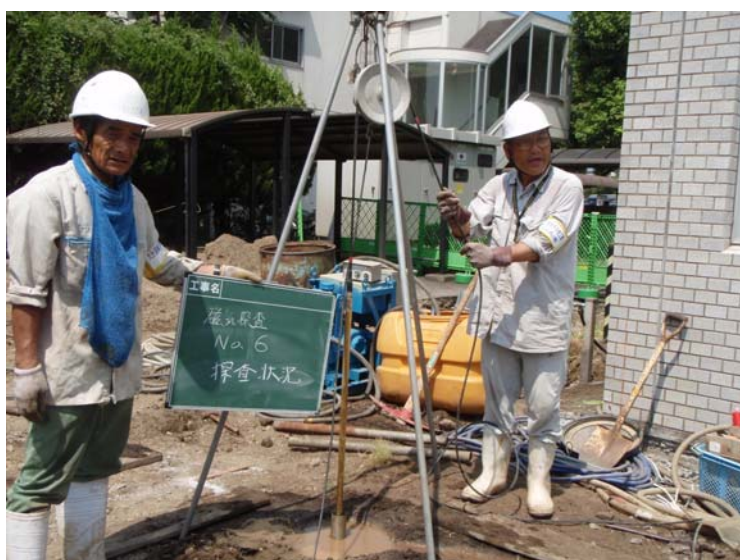
鉛直探査状況
