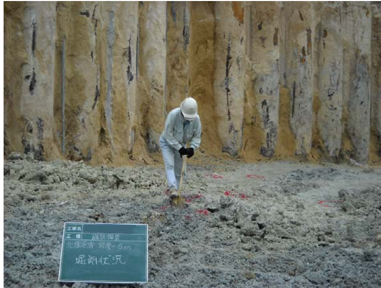
異常点の人力掘削状況
