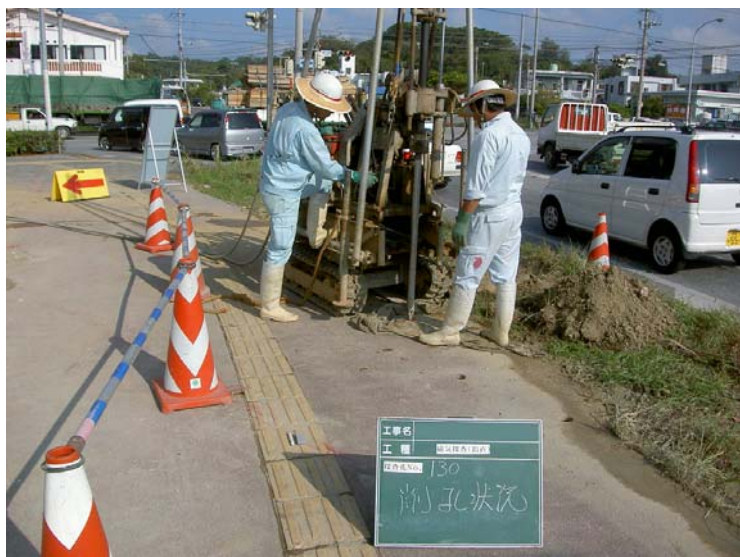
ボーリングマシンによる掘進状況
