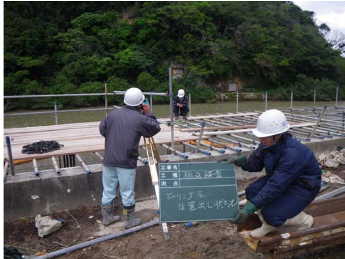
測量状況（鉛直探査）
