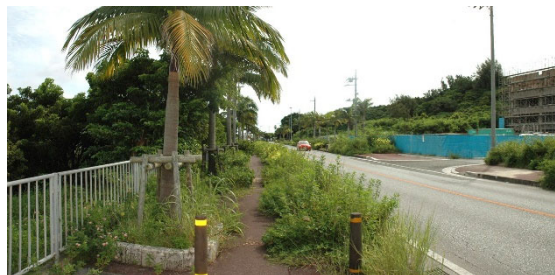
国道 331 号 (南城市)
