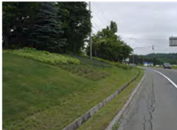
官民、官官の連携により、道路と沿道の緑地の一体整備を行う 庭園、公園の造成管理の連携例 出典：23
