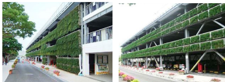
オオタニワタ、オキナワハイネズ、オキナワシャリンバイなどによる壁面緑化 海洋博公園北ゲート立体駐車場（本部町）
