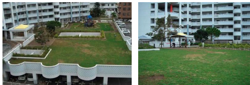
コウライシバ、イワダレソウなどの地被植物による屋上緑化 県営天久高層住宅立体駐車場（石垣市）
