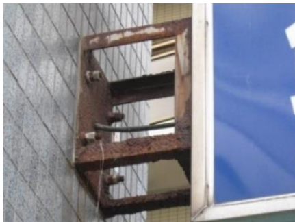
ブラケット・取付部の腐食 (ブラケット)
