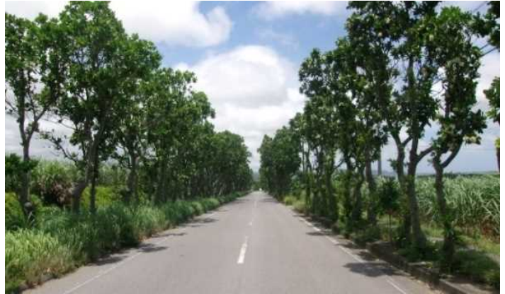
約 1メートル間隔で高木が植栽され、機械による作業が行えない
