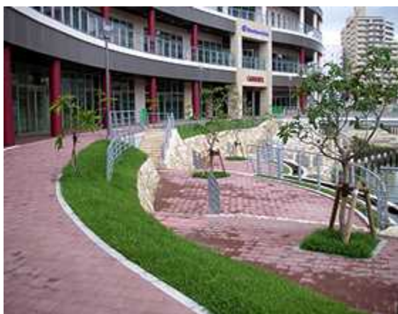
牧志・安里再開発に係る安里川河川改修工事におけるセンチピードグラス（ティブブレア）による法面防草
