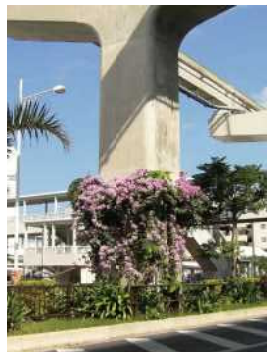
モノレール柱脚緑化
