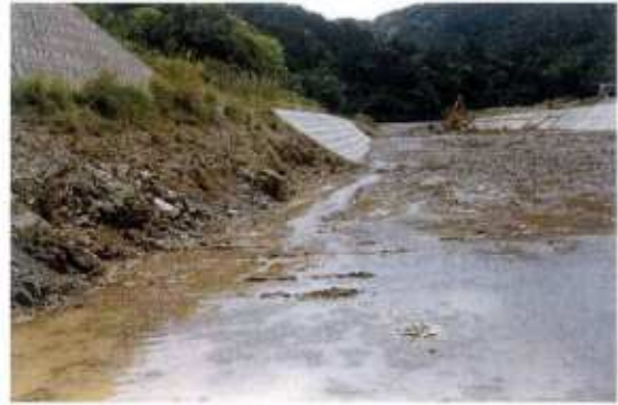
河川改修工事の状況
