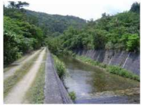
コンクリート護岸
